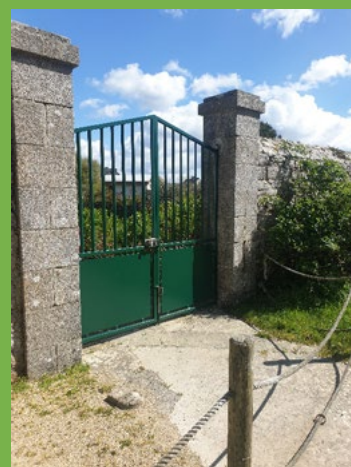
Travaux de peinture du portail au phare de Trézien.
