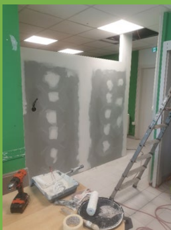
Travaux de cloisonnement au centre nautique NPI.
