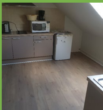
Réfection du sol et des peintures au logement d'urgence de Plouarzel.
