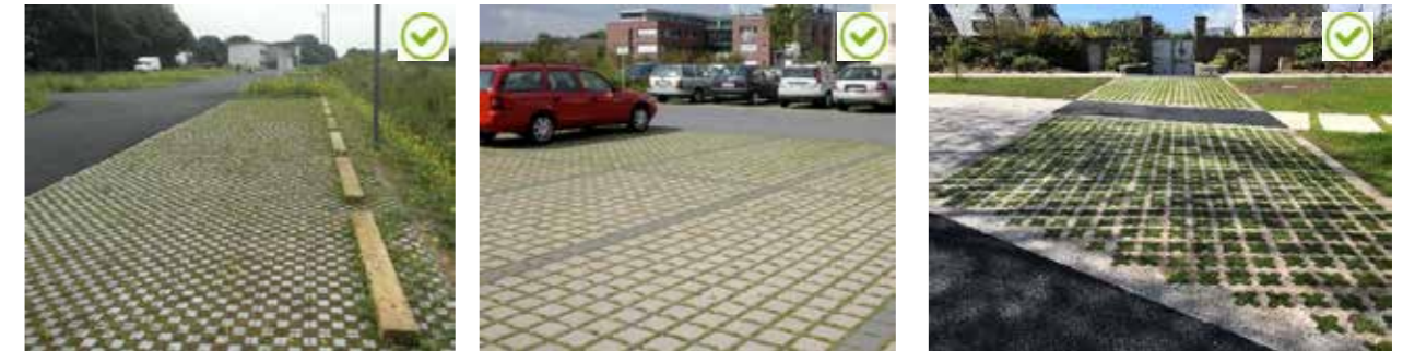
Dalle béton avec joints gazon
