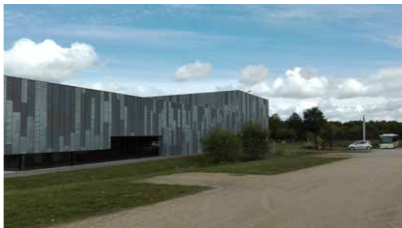
Salle polyvalente avec parking vert et noue - Bouvron
